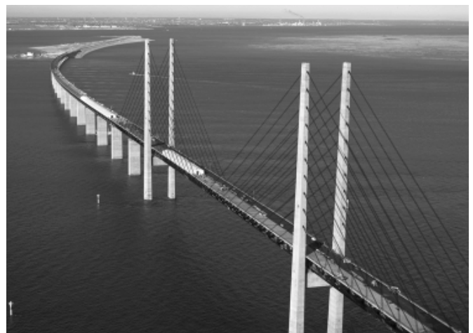
High Bridge Section of Øresund Fixed Link (Øresundskonsortiet)
